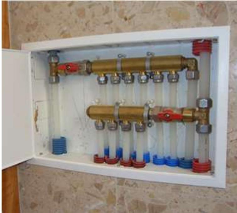
Figura 3 - Detalhamento caixa de coletores. Fonte: Lenhasol, 2019
