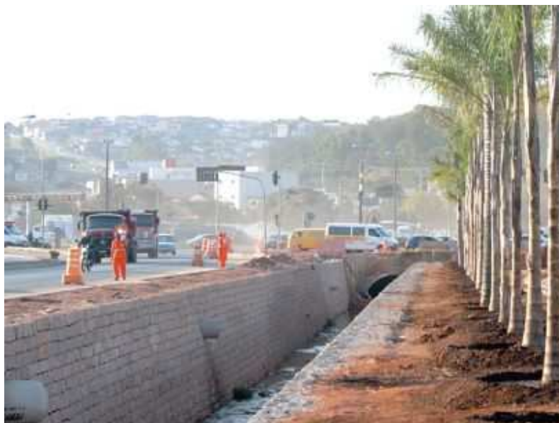
Figura 3 – Canalização do rio e colocação de palmeiras na Av. Nove de Julho. Fonte: Rede Bom Dia (2010)
