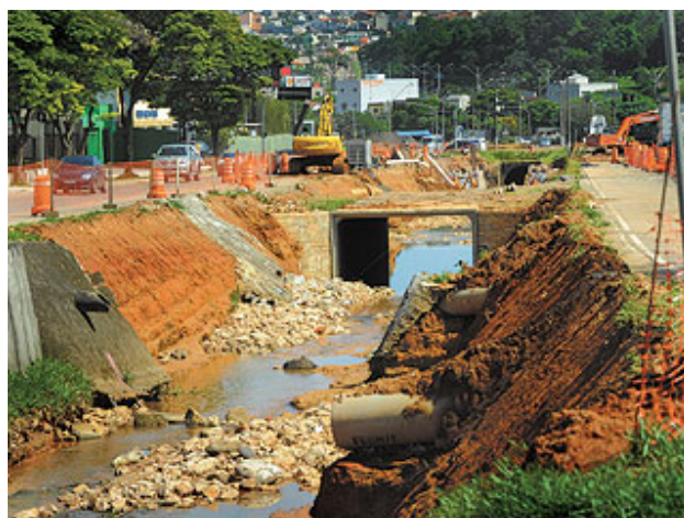
Figura 3 – Canalização do rio na Av. Nove de Julho. Fonte: Jornal de Jundiá (2010)
