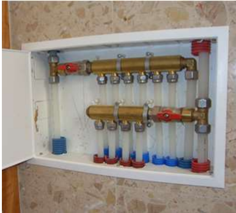
Figura 3 - Detalhamento caixa de coletores. Fonte: Lenhasol, 2019
