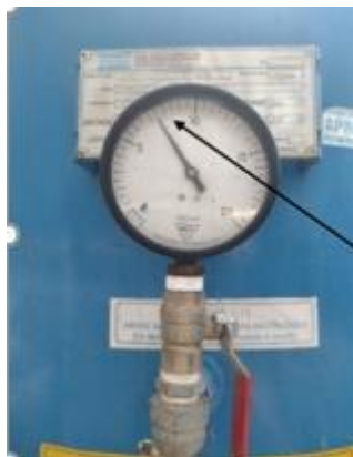
Figura 1: Pressão no tanque principal não reduzia durante sopragem, havendo uma oscilção desconsiderável. Fonte: Dos autores, 2023
