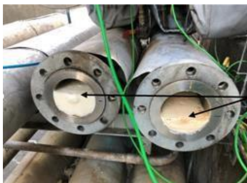
Figura 2: Imagem de duas tubulações abertas para limpeza. Produto parado e cristalizado nas tubulações por ineficiência das sopragens, ocasionando obstrução e contaminação cruzada entre os produtos alterando os padrões e gerando reprocessos. Fonte: Dos autores, 2023.
