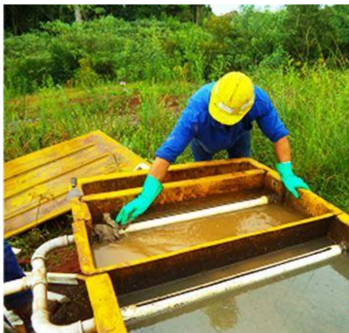
Figura 9 – Limpeza da caixa separadora água e óleo
