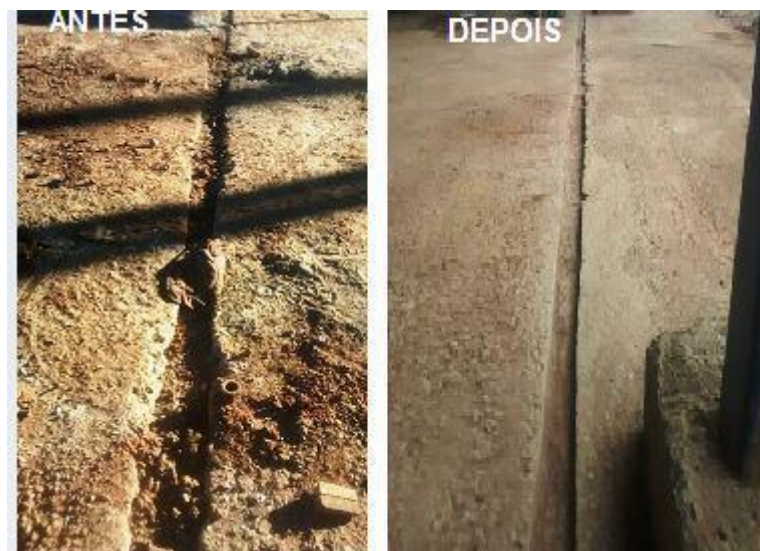
Figura 3 – Canaletas antes e após a limpeza
