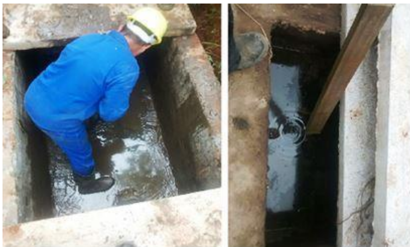
Figura 8 – Caixa de sedimentação sendo limpa (esquerda) e após a limpeza (direita)
