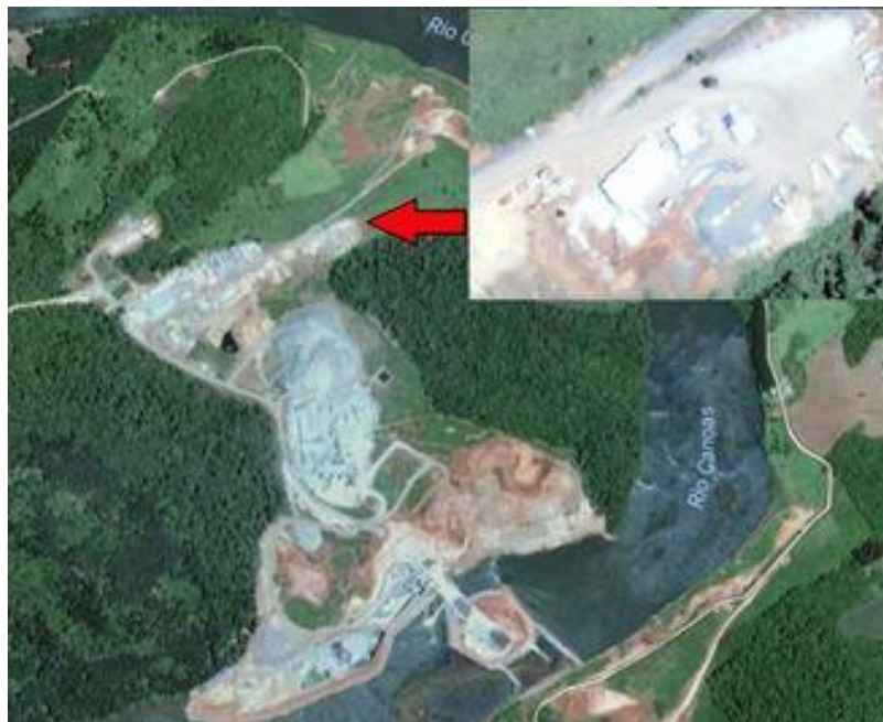
Figura 1 – Obra da Usina Hidrelétrica São Roque, com detalhe do local onde está instalada a oficina mecânica
